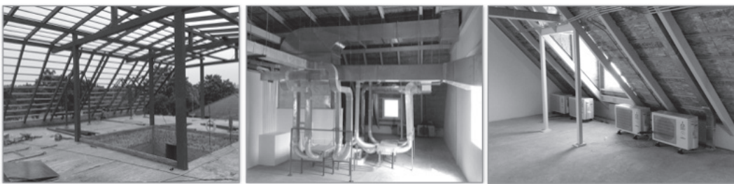
รูปที่ 6 โครงหลังคาเป็นโครงสร้างเหล็ก มีพื้นที่ภายในห้องใต้หลังคาเพื่อวางงานระบบ ที่มา: ผู้วิจัย (2558)
