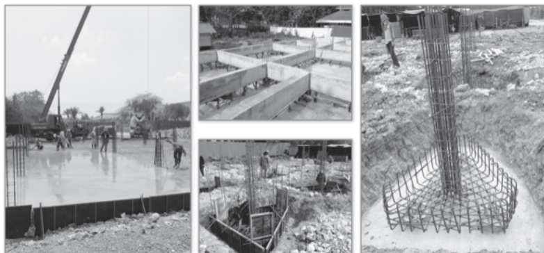
รูปที่ 4 จากขัายการเทพื้นชั้นใต้ถุน โครงสร้างคานระดับพื้นชั้นหนึ่ง 1.20 เมตร และขนาดเสาตอม่อ ที่มา: ผู้วิจัย (2556 - 2557)
