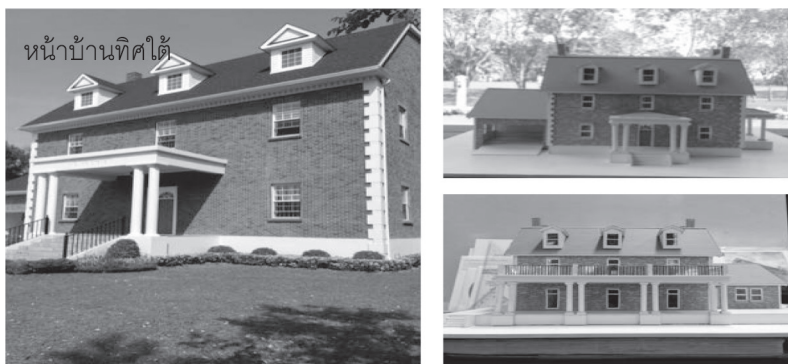
รูปที่ 3 รูปอาคารที่สร้างแล้วเสร็จ เปรียบเทียบกับหุ่นจำลองที่ดำเนินการทำไว้ในช่วงของการออกแบบ ที่มา: ผู้วิจัย (2557)
