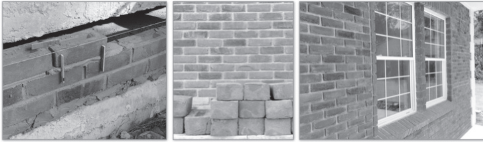
รูปที่ 5 จากซ้าย การเรียงอิฐที่ละก้อนต้องใช้การวัดระดับที่ดี ขนาดของอิฐที่มีความหนา และการใส่รายละเอียดช่องเปิดของหน้าต่าง เช่น วงกบล่างที่ต้องเอียงก่อนอิฐออกเพื่อการระบายน้ำที่ดี ที่มา: ผู้วิจัย (2558)
