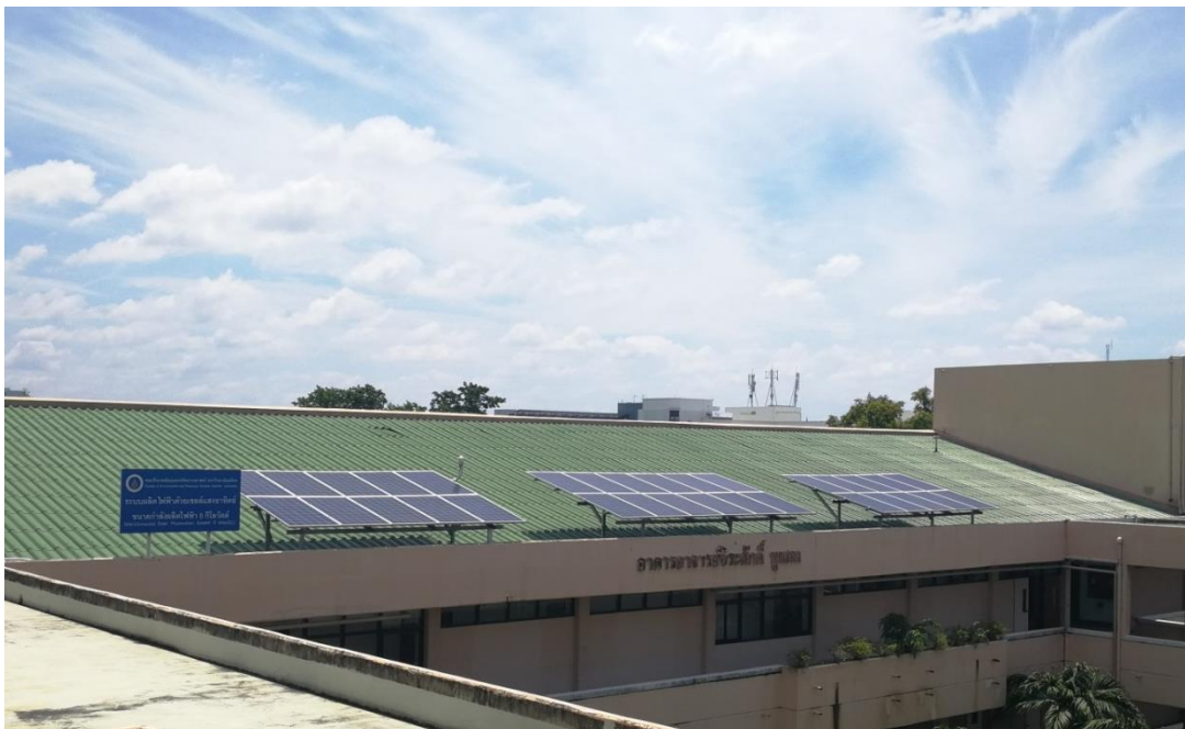
ภาพที่ 1 ระบบผลิตไฟฟ้าพลังงานแสงอาทิตย์ขนาด 8 กิโลวัตต์ คณะสิ่งแวดล้อมและทรัพยากรศาสตร์ มหาวิทยาลัยมหิดล
